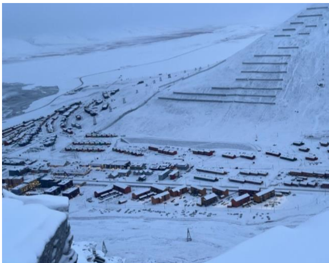
Longyearbyen med skredsikringstiltak (Foto: E.Albrechtsen)
