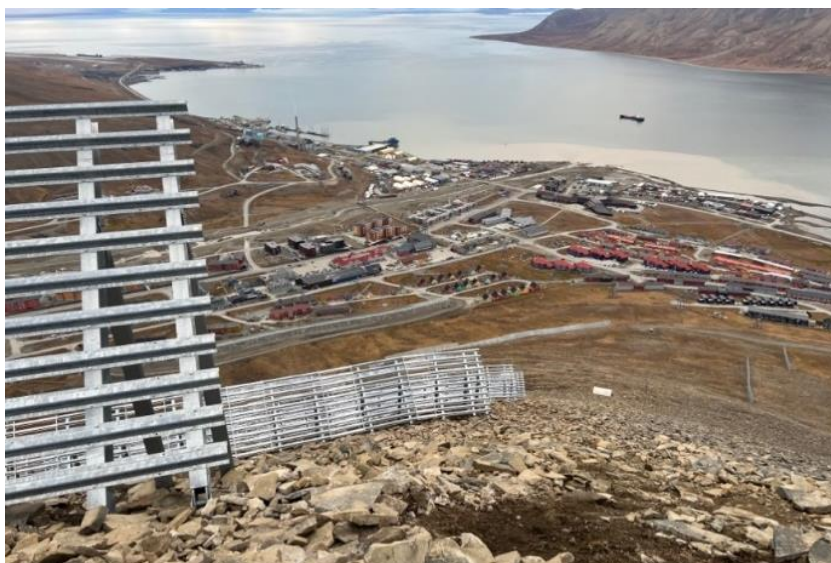
Støtteforebygninger, fangvoll og snøgjerdar sett fra øverste del av Sukkertoppen. Foto: Eirik Albrechtsen
