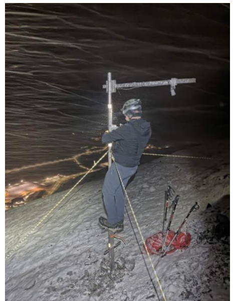
Montering av snøsensor Gruvefjellet (Foto: H.Hancock)
